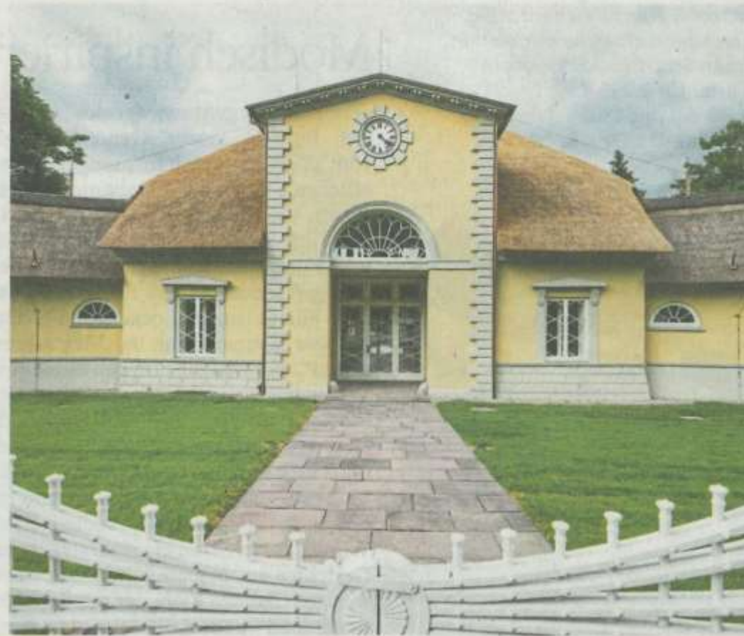
Die Remise am Halbmondsweg an der Elbchaussee
