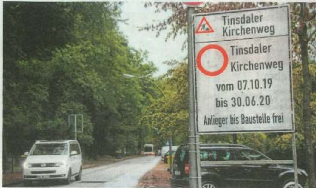
Die Arbeiten im Tinsdaler Kirchenweg starten am 7. Oktober.
